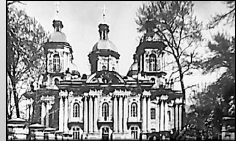
Колонны и полуколонны. Пучки колонн. Никольский морской собор. Архитектор С. И Чевакинский 1753—1762. Санкт-Петербург
