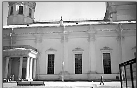
Северный портик Петропавловского собора Петропавловской крепости. Д. А. Трезини (при участии И. Устинова и М. Г. Земцова). 1712—1733. Санкт-Петербург
