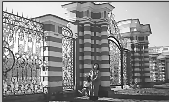
Кованая золоченая решетка центрального въезда во внутренний двор Большого (Екатерининского) дворца в Царском Селе (ныне г. Пушкин). Архитектор Б. Растрелли. 1752—1757 гг.
