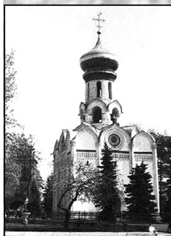
Церковь-звонница во имя Сошествия Святого Духа на Апостолов (1476), или Духовская церковь, сооружена псковскими мастерами. Троице-Сергиева лавра
